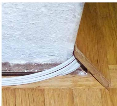
... oder einfach und platzsparend hinter Fußleisten, Türrahmen etc. verlegt.
