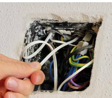
Das dünne POF Kabel wird in die bestehende Elektroinstallation eingezogen...
