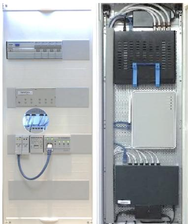
Hier wurden neben dem POF 6+2 Port Switch auch der Router und ein SAT>IP Server neben dem Stromverteiler im Multimedia Schrank untergebracht.
