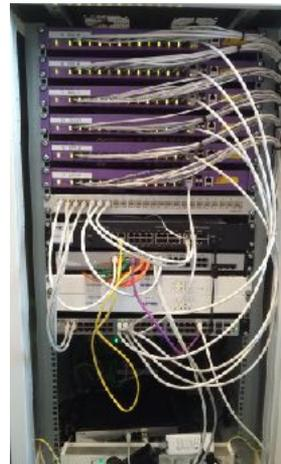
In diesem Netzwerkschrank sind mehrere POF 12+4 Port Switches untereinander verbunden und bieten jede Menge Zugangsmöglichkeiten in den einzelnen Hotelräumen.
