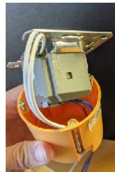
Die POF Kabel sind geparkt. Zur Aktivierung werden die geparkten Kabel an einen Switch angeschlossen.
