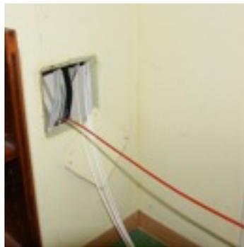
Vier POF Kabel wurden durch das bestehende Verbindungsrohr gezogen um eine sternförmige Verteilung zu installieren.
