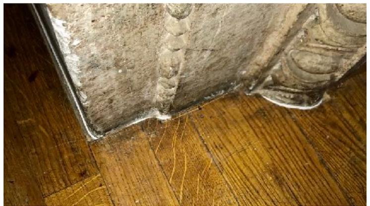
Für die Verlegung des dünnen POF Kabels wurde sowohl die bestehende Elektroinstallation, so wie jede verfügbare Ritze genutzt. Sogar die erforderlichen Biegeradien wurden eingehalten.
