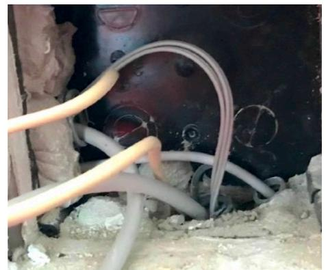
Das POF-Kabel wurde nachträglich über die bestehenden Rohre der Elektroinstallation und der Koaxialverkabelung im Hotel installiert.
