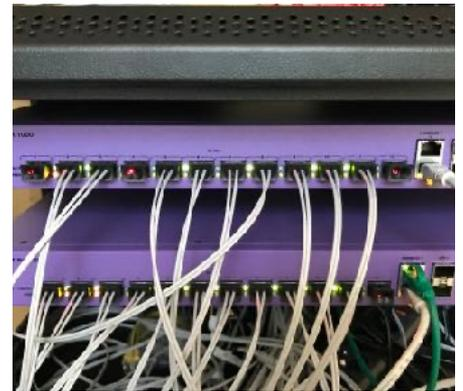
Die Gigabit-Switches der Netzwerk-Cluster wurden je nach verfügbarer Verkabelung örtlich angepasst untergebracht.
