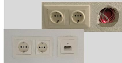
Sternverkabelte Elektroinstallation mit POF Lichtwellenleiter kombiniert
