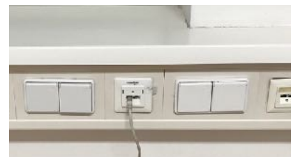
INSTALLATION IM AUFPUTZ KABELKANAL
