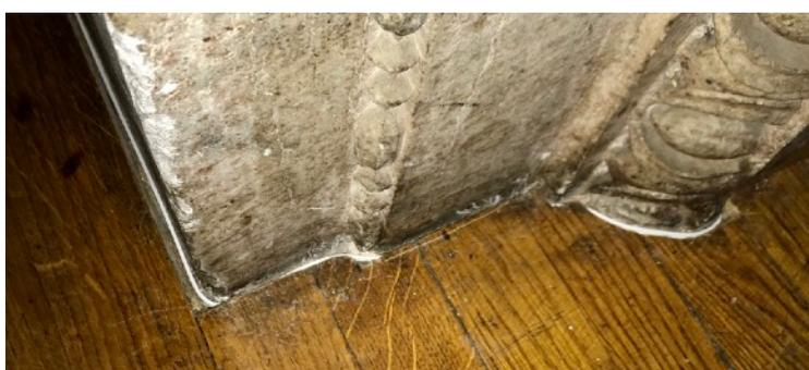
Il cavo POF è stato preferibilmente inserito nelle tubature elettriche esistenti. Per l'installazione è stato possibile utilizzare anche vari spazi vuoti nel pavimento. Il raggio di curvatura minimo richiesto di 2 cm è stato sempre rispettato.
