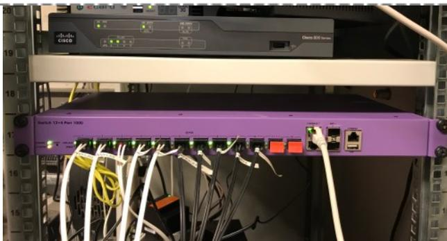
I cavi esistenti sono stati semplicemente collegati al nuovo Switch Gigabit di Homefibre. Sono state tagliate solo le estremità dei cavi.
