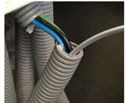
Il cablaggio POF è stato inserito nei tubi dell'impianto elettrico esistente. I singoli fili sono stati riuniti in una configurazione a stella nel distributore elettrico centrale.
