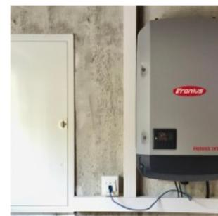
Il cavo POF è stato instradato con l'impianto elettrico nel distributore elettrico e nel distributore multimediale posto accanto ad esso. Lì è stato collegato allo switch POF posizionato dietro il router Internet.
