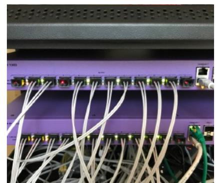
Gli switch Homefibre POF con capacità Gigabit sono stati installati in base alle sezioni di costruzione e al cablaggio POF.
