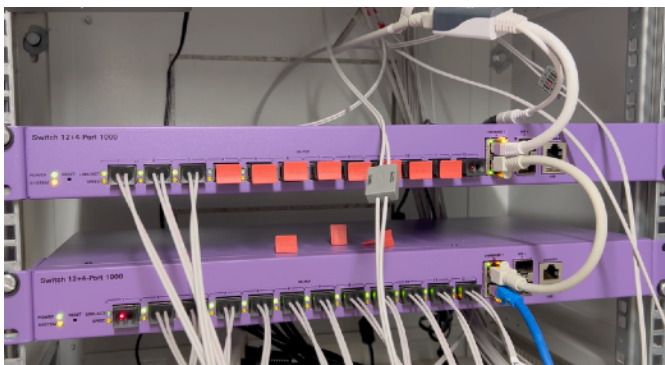
2 x OMS 1412 im 19-Zoll Schrank über RJ45 mit dem Router und untereinander verbunden (gestackt).
