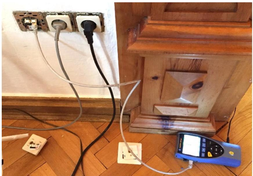
Sanierung der Elektroinstallation mit der POF-Gigabit-Verkabelung in einem historischen Gebäude.
