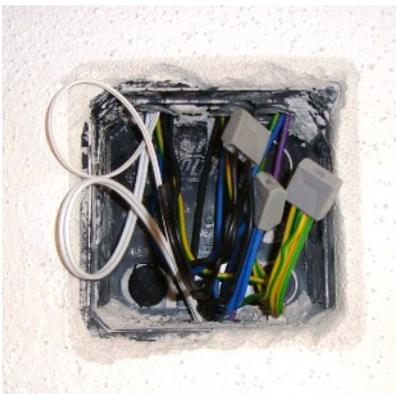
POF in der Nachverkabelung für WLAN-Access-Points über die Elektroinstallation.
