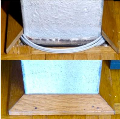
Verlegung von 4 POF-Leitungen hinter einer Fußleiste.
