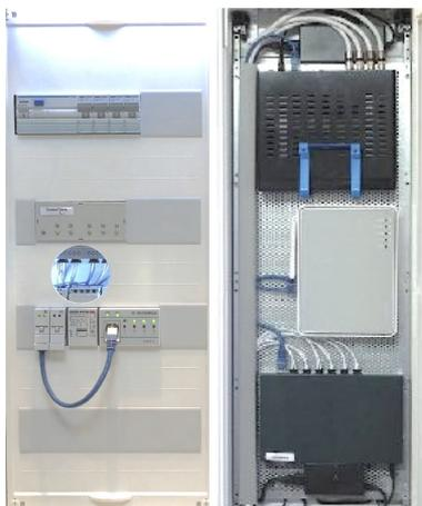
Hier wurden neben dem POF 6+2 Port Switch auch der Router und ein SAT>IP Server neben dem Stromverteiler im Multimedia Schrank untergebracht.
